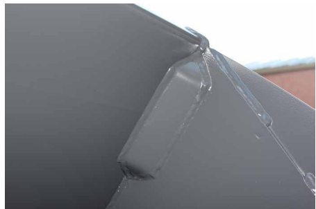
Verstärkungen in allen vier Ecken
